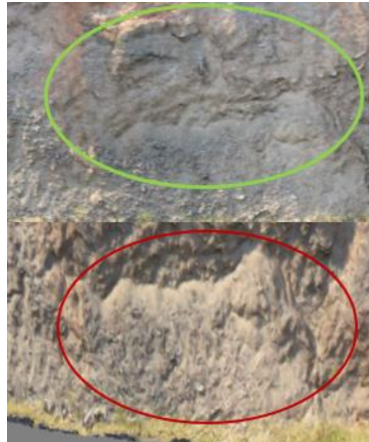
รูปที่ 9 การเกิดลักษณะดินตดบริเวณลาดดินดินแดง
