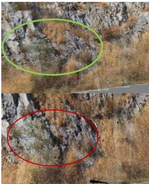
รูปที่ 12 การเกิดลักษณะดินถล่มบริเวณลาดดินหินผุ
