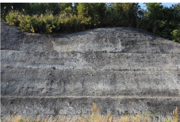
รูปที่ 3 พื้นที่ลาดดินคอนกรีตพ่น
