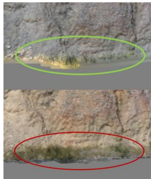
รูปที่ 10 การเกิดลักษณะดินถล่มบริเวณลาดดินดินแดง
