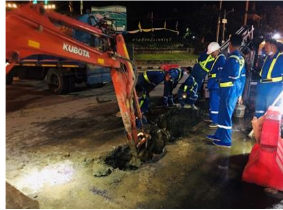
รูปที่ 1 งานก่อสร้างระบบไฟฟ้าใต้ดินของกรไฟฟ้าส่วนภูมิภาค
