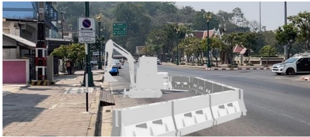
รูปที่ 13 แบบจำลอง AR ในการวางตำแหน่งเครื่องจักรขุดเปิดหน้าดิน
