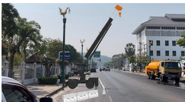
รูปที่ 15 แบบจำลอง AR ในการติดตั้งเครนเพื่อเตรียมยกบ่อกักสายไฟฟ้า
