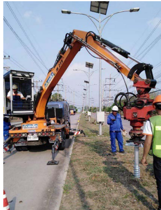
รูปที่ 5 การติดตั้งเสาไฟฟ้าโดยใช้เสาเข็มเหล็กเป็นฐานราก
