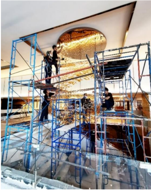
รูปที่ 1 การทำงานบนที่สูงที่ต้องใช้นั่งร้านค้ำยัน
