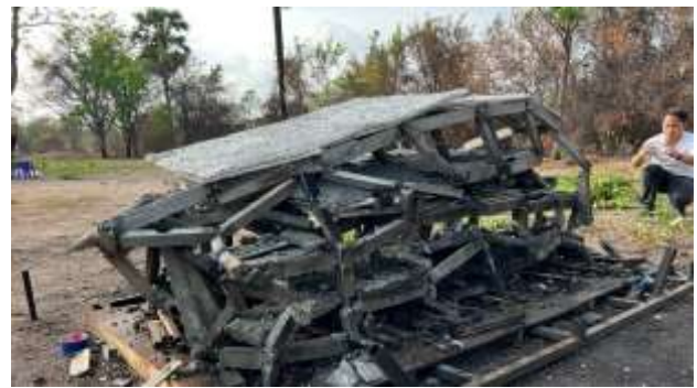
รูปที่ 7 การพังทลายหลังระเบิด แบบจำลองอาคารคอนกรีตเสริมเหล็ก
