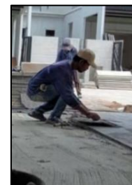
รูปที่ 7 การปูกระเบื้องและเคาะเพื่อตรวจสอบว่ามีโพรงด้านในหรือไม่
