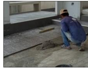
รูปที่ 4 การเทมอร์ตาร์บริเวณแนวปูกระเบื้อง
