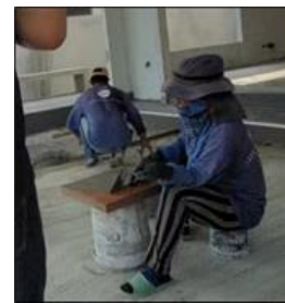
รูปที่ 6 การปาดกาวซีเมนต์หลังกระเบื้อง
