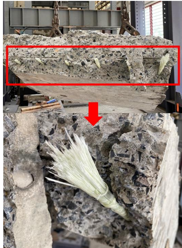
รูปที่ 6 การวิบัติของแท่ง GFRP (พื้นตัวอย่าง C40)
