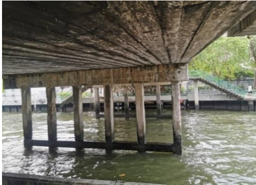
รูปที่ 1 ตัวอย่างเสาเข็มที่ต้องการทราบความยาวที่มีข้อจำกัดด้านพื้นที่ทดสอบ
