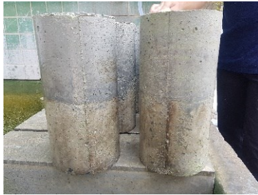
รูปที่ 4 ตัวอย่างคอนกรีตหลังหล่อคอนกรีตใหม่ลงบนคอนกรีตเดิม
