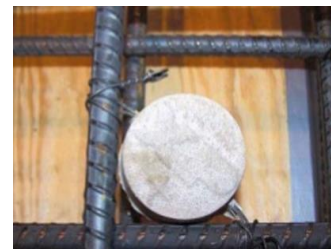
รูปที่ 5 การติดตั้งแอนโอด
