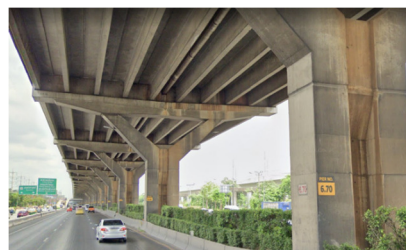
รูปที่ 1 ทางยกระดับ และถนนพื้นราบ
