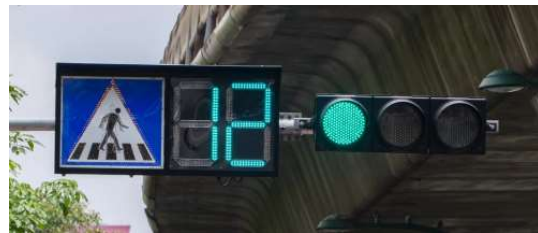
รูปที่ 5 สัญญาณไฟจราจรทางข้าม
