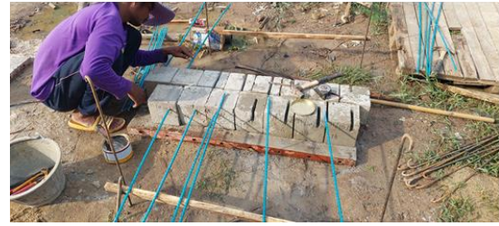
(ค) การกรีดร่องและติดตั้ง GFRP ด้วยน้ำยาประสานอีพ็อกซี
