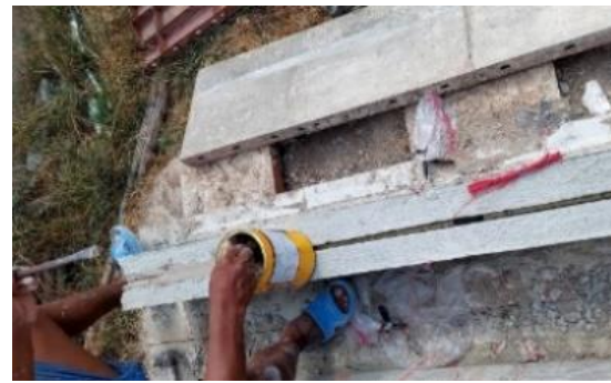
(ข) ภาพแสดงการติดตั้ง GFRP ลงในร่องด้วยอีพ็อกซี
