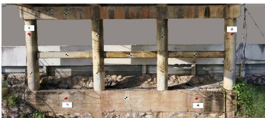
รูปที่ 5 การวางจุดควบคุมภาพถ่ายบริเวณตอม่อสะพาน
