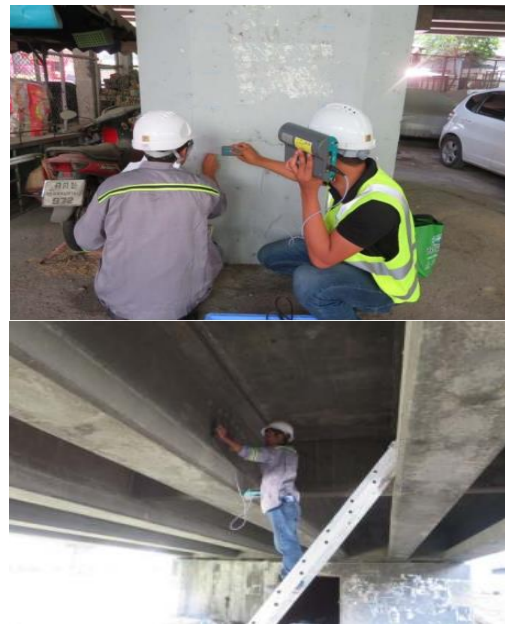
รูปที่ 6 การตรวจวัดระยะคอนกรีตหุ้มเหล็กเสริมด้วยวิธีการเหนี่ยวนำของสนามแม่เหล็กไฟฟ้า (Electromagnetic Induction)
