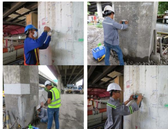
รูปที่ 3 การทดสอบโครงสร้างคอนกรีตเสริมเหล็กด้วยวิธีแบบไม่ทำลาย (Non-Destructive Testing)
