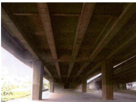
รูปที่ 2 ลักษณะของโครงสร้างทางยกระดับของทางพิเศษเฉลิมมหานคร
