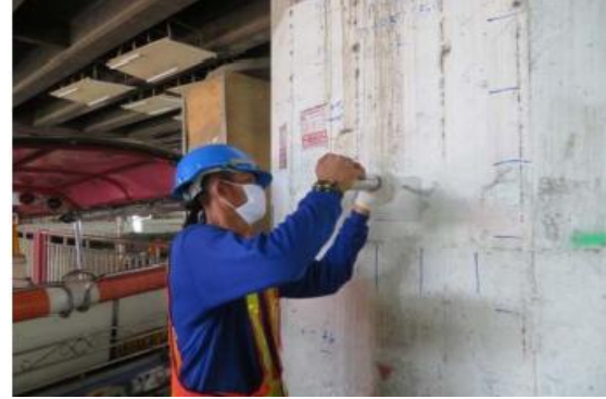
รูปที่ 5 การตรวจสอบหาค่าความแข็งแรงของคอนกรีตด้วยค้อนกระทบ (Rebound Hammer)
