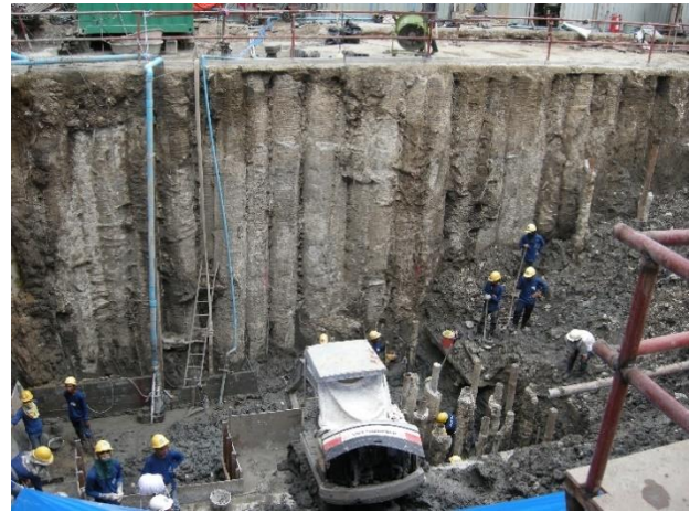
รูปที่ 9 ภาพถ่ายขณะขุดดินที่ระดับความลึกสูงสุด 7.4 เมตร
