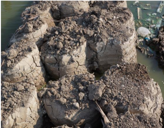
รูปที่ 10 การแยกจากกันของ SCC บริเวณรอยต่อระหว่างต้นเมื่อเกิดการร่วบิต
