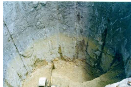
รูปที่ 1 การขุดเพื่อก่อสร้างปล่องที่ระดับความลึก 21 เมตร เมื่อปี ค.ศ. 1997 ดินกันบ่อแห่งนี้ไม่มีน้ำใต้ดินเข้ามาในบ่อ
