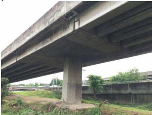
รูปที่ 4 รอยต่อของโครงสร้างสะพาน รูปแบบ Half Joint
