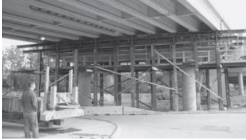
รูปที่ 1 การยกโครงสร้างส่วนบนโดยวิธีการใช้คานหมุน
