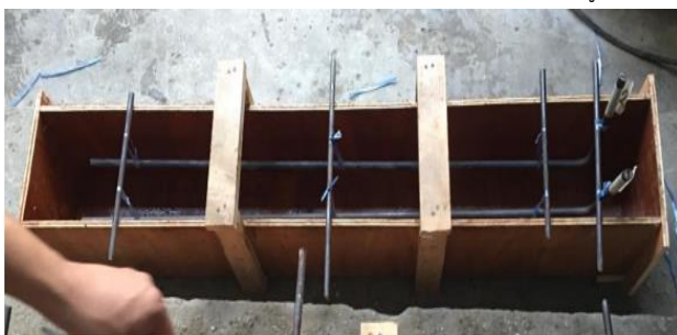
รูปที่ 3 การติดตั้งเหล็กเสริมคอนกรีตในแบบหล่อคาน
