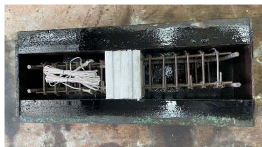
รูปที่ 3 การเตรียมวัสดุก่อนหล่อคาน
