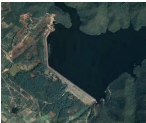
รูปที่ 1 ภาพถ่ายทางอากาศ เขื่อนแม่งัดสมบูรณ์ชล
