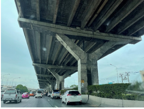
รูปที่ 1 ทางยกระดับคอนกรีตในเมือง
