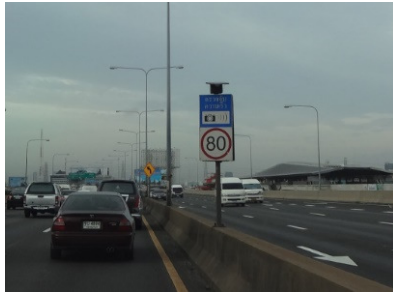
รูปที่ 2 ป้ายจำกัดความเร็วบนทางยกระดับ
