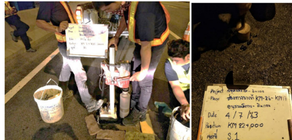
รูปที่ 4 การเจาะตัวอย่างแอสฟัลต์
