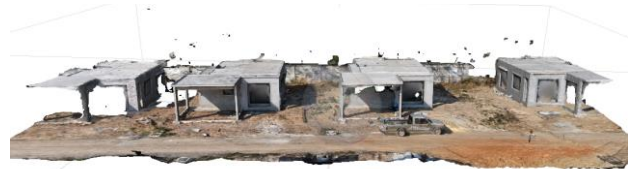
รูปที่ 4 แบบจำลอง 3 มิติอาคารเมื่อแล้วเสร็จ 1 ชั้น
