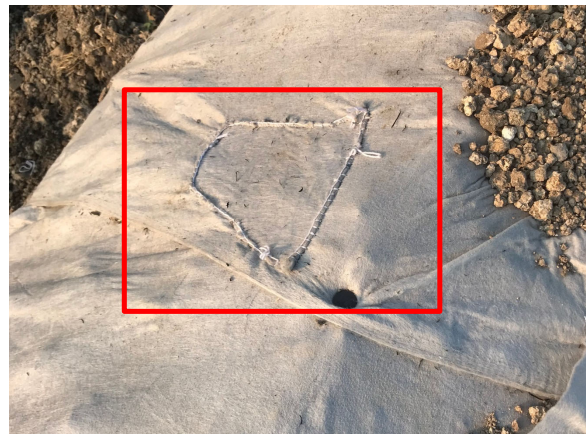
รูปที่ 18 การเย็บซ่อมแซมบริเวณที่ขาด
