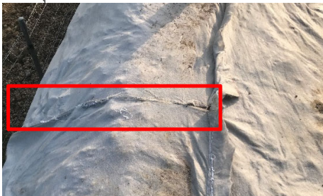
รูปที่ 17 รอยต่อแผ่นใยสังเคราะห์
