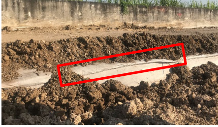
(ก) Geotextile ที่ไม่ติดตั้งทำให้ดินไหลเข้ามาในช่องว่าง
