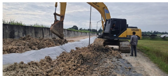
รูปที่ 14 การถมดินในชั้นที่ 2 ในกรณีที่มี Geotextile
