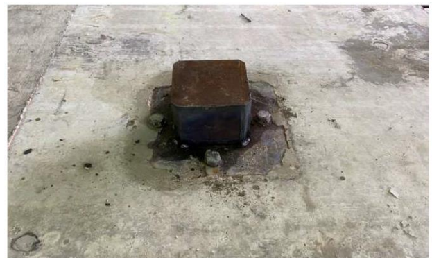
รูปที่ 12 การติดตั้งแท่งเหล็กสี่เหลี่ยมตันที่จุดรับแรงจากแม่แรงไฮดรอลิกใต้แผ่นพื้น
