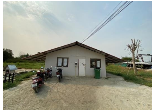
รูปที่ 2 สำนักงานโรงหล่อ
