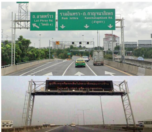
รูปที่ 1 ลักษณะของโครงเหล็กคร่อมทางบนทางพิเศษ
