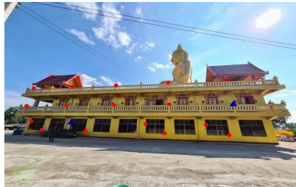
รูปที่ 4 จุดควบคุมภาคพื้นดินและจุดทดสอบอาคารคอนกรีตเสริมเหล็ก
