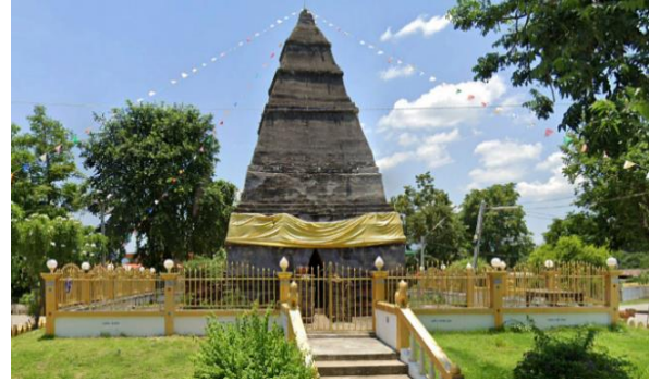
รูปที่ 3 อาคารโบราณสถาน
