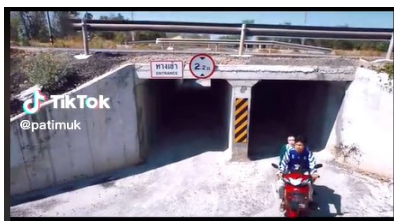
รูปที่ 23 ทางลอดขนาดเล็กออกแบบให้น้ำไหลผ่านได้ดี (ไม่ค้ำท่อ) (ที่มา : TikTok Creator @patimuk)
