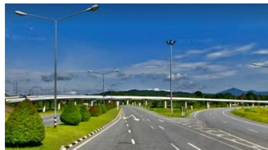
รูปที่ 26 การติดตั้งไฟฟ้าแสงสว่างบริเวณทางแยกต่างระดับ (ที่มา : ภาพจาก Google earth ทางหลวงหมายเลข 418)
