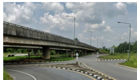
รูปที่ 9 สะพานข้ามทางแยกแบบวงเวียน (ที่มา : ภาพจาก Google earth ทางหลวงหมายเลข 418)
