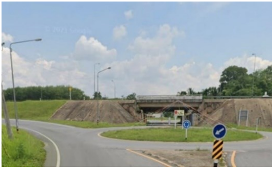
รูปที่ 11 ทางแยกต่างระดับแบบวงเวียนคู่ (ภาพด้านข้าง) (ที่มา : ภาพจาก Google earth ทางหลวงหมายเลข 418)
