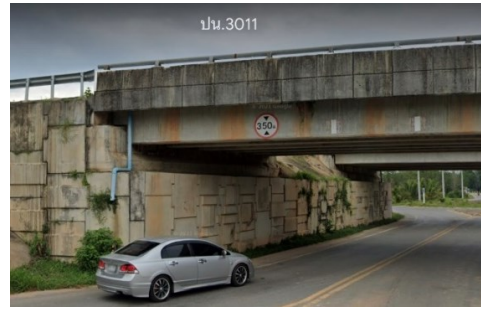
รูปที่ 18 การใช้งานทางลอดบริเวณทางต่างระดับวงเวียนคู่ (ที่มา : ภาพจาก Google earth ทางหลวงหมายเลข 418)
