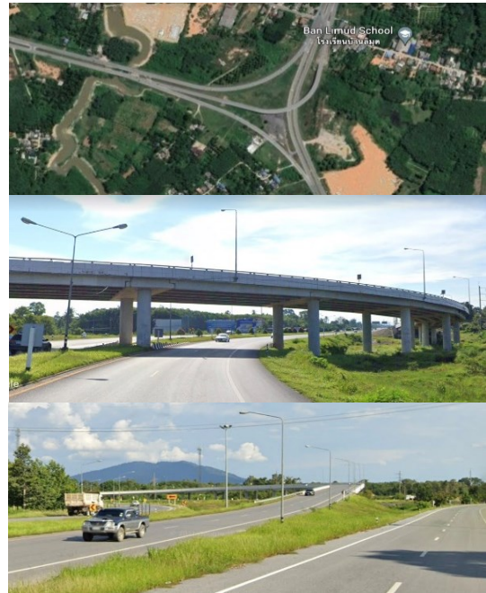
รูปที่ 28 ทางหลวงหมายเลข 418 สาย ปัตตานี - ยะลา (ที่มา : ภาพจาก Google earth ทางหลวงหมายเลข 418)
