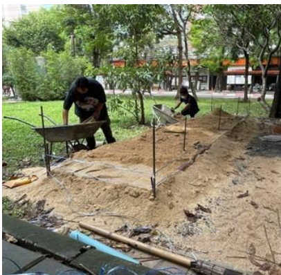
รูปที่ 10 ก่อสร้างสนามทดสอบด้วยชั้นทรายบดอัด
