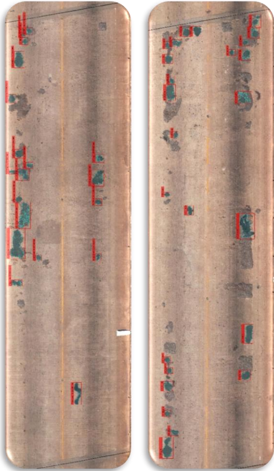
รูปที่ 14 การประมวลผลความเสียหายจากแผนภาพความละเอียดสูง (Ortho-image) ของสะพานช่วง Span 1 และ Span 4
