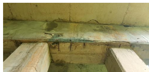
รูปที่ 10 ภาพความเสียหายของคานรัดหัวเสา
