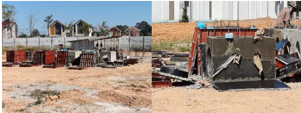
ง. การรื้อให้คอนกรีตแข็งตัว และการแกะแบบออก
