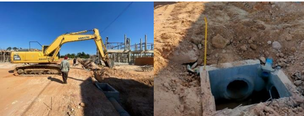
ช.การถมดินบนแนวท่อ เพื่อทำการบดอัดชั้นที่ 1 ต้องมีการบ่มน้ำเพื่อให้ดินแทรกลงไปทั่วถึงในแนวด้านใต้ท่อ โดยทำการบ่มน้ำไว้ 6-8 ชั่วโมง หลังจากนั้นทำการตรวจระดับปากบ่อพักว่าต้องทำการปรับแก้ระดับปากบ่อพักหรือไม่ก่อนทำการถมเพื่อบดอัดและบ่มในชั้นสุดท้าย
