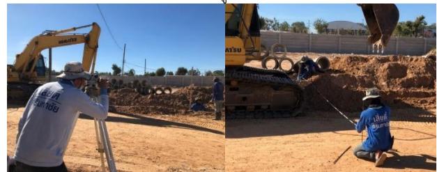
ก. การทำแนวพิกัดแนวระดับการขุด และการตรวจสอบแนวขุดก่อนการขุด
