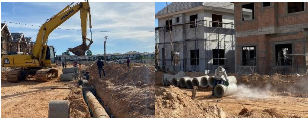
จ.วางท่อบนพื้นร่องที่มีคอนกรีตหยาบ เริ่มจากระดับที่ต่ำไปหาระดับที่สูง โดยท่อตอนแรกให้หันด้านรางเข้าด้านที่รับน้ำ ส่วนท่อที่สองให้ใช้ด้านที่เป็นลิ้นสวมเข้ากับด้านที่เป็นรางของท่อแรก สวมท่อต่อกันไปจนบรรจบกับบ่อพัก หากระยะไม่พอดีให้ใช้วิธีการตัดท่อตามระยะที่ต้องการ
