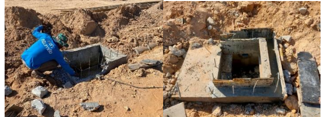
ข.ตรวจสอบและปรับแก้ปากบ่อพักที่ไม่ได้ระดับ ตามแบบ หรือตามวิศวกรกำหนด ซึ่งอาจจำเป็นต้องทุบและหล่อขึ้นใหม่เพื่อให้มีระดับที่สอดคล้องกับถนน
