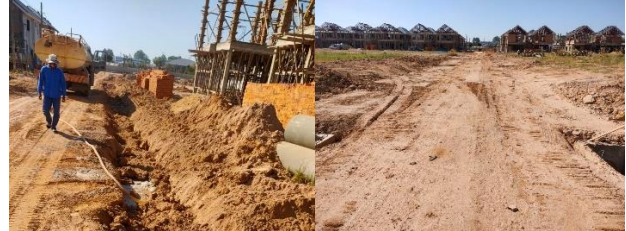
ฉ.การถมและบดอัดเป็นชั้นๆ พร้อมกับบ่มน้ำเพื่อให้ดินเข้าไ้แทรกบดรอยต่อท่อด้านล่าง ในการบ่มและบดอัดจะแบ่งออกเป็น 2 ชั้น บ่มประมาณ 6-8 ชั่วโมง โดยดินที่ถมหลังท่อ คสล. ต้องสูงจากหลังท่อคอนกรีต ไม่น้อยกว่า 40 cm
