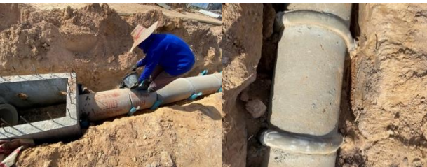
ฉ.ยาแนวรอยต่อท่อ ด้วยปูนทราย(MORATA) 1:2 (ปูน 1 ส่วน : ทราย 2 ส่วน) โดยใช้ปูนทรายยาแนว กว้าง 12 ซม. หนา 5 ซม. ซึ่งใช้ท่อ PVC เป็นแบบหล่อในการยาแนว และยึดท่อเข้าด้วยกัน หลังยาแนวเสร็จต้องปล่อยให้แห้ง เป็นเวลา 3 วัน จึงสามารถที่จะทำการถมดินเพื่อบดอัดชั้นที่ 1 ได้
