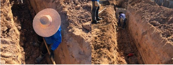
ค.ปรับระดับพื้นร่อง เซ็คระดับปากท่อ โดยการดึงหมุดระดับ เพื่อเตรียมเทลิ้น
