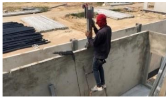
รูปที่ 5 การติดตั้งตั้ง
