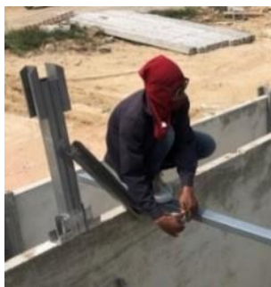
รูปที่ 7 ติดตั้งค้ำยัน
