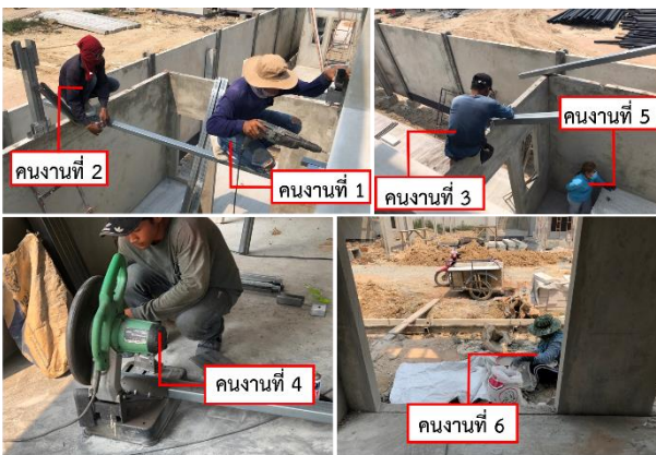
รูปที่ 1 กลุ่มคนงานในการติดตั้งโครงสร้างหลังคาเหล็ก
