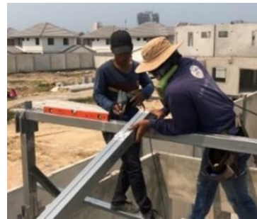
รูปที่ 9 การติดตั้งจันทัน
