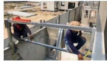
รูปที่ 8 การติดตั้งออกไก่
