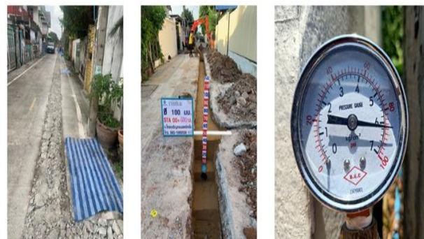
ดำเนินการเจาะผิวจราจร ระยะทางไม่เกินกิจกรรมสั้น ๆ ที่ทำได้ในวันทำการคือวันละประมาณ 100 เมตร เพื่อลดข้อร้องเรียนเรื่องขุดแล้วไม่กลบ ที่ส่งผลกระทบต่อความน่าเชื่อถือของโครงการได้ โดยระบุเงื่อนไขลงในสัญญา
