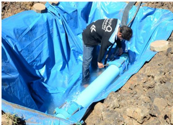
บังคับใช้การติดตั้งระบบท่อประปาโดยใช้ฉนวนน้ำดำไม่เพื่อป้องกันสิ่งสกปรกเข้าประปาภายในพื้นที่เพื่อลดข้อร้องเรียนเนื่องด้วยประปาขุ่น
