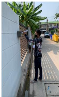
ประชาชนที่อาศัยบ้านเรียงระดมช่วยกันขุดลอกและฝังท่อประปา 1 วัน ก่อนดำเนินการปิดถนนเพื่อติดตั้งท่อประปา เพื่อลดข้อร้องเรียนเนื่องด้วยผิวงานขรุขระไม่เรียบ
