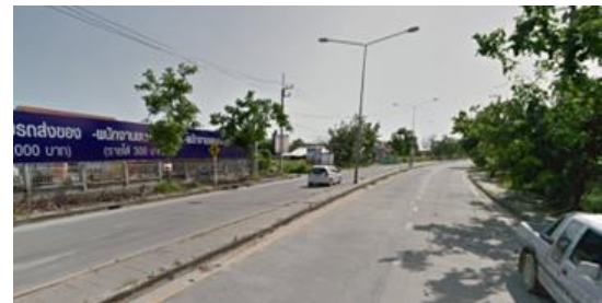
รูปที่ 4 ตัวอย่างหน้าตัดถนนเขตทาง 20 เมตร (มีเกาะกลาง)
