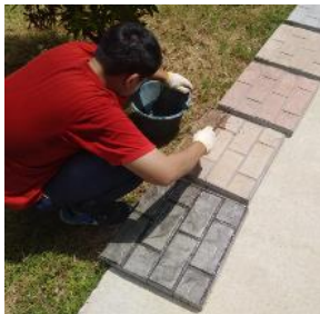
รูปที่ 14 ทาน้ำยาเคลือบเงาใสกันซึม
