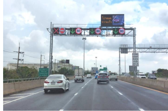
รูปที่ 3 แสดงลักษณะการติดตั้งและการแสดงผลของป้าย LED ควบคุมช่องทางและป้าย LED แสดงข้อความ/ภาพ ที่บริเวณ กม. 12+500, 13+500, 14+000
