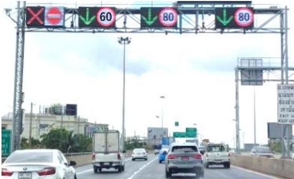
รูปที่ 7 แสดงสัญลักษณ์จราจร ข้อความ และตัวเลขความเร็วของป้ายแสดงผล LED ขนาด 1x1 เมตร ตามค่าพื้นฐานของระบบฯ (Default) บริเวณ กม. 13+500 ฝั่งขาออก
