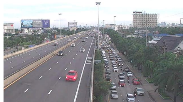
รูปที่ 1 ลักษณะทางกายภาพและปริมาณรถพื้นราบบริเวณทางลง
