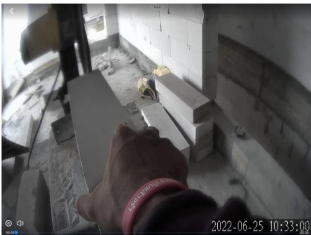
รูปที่ 9 ภาพจากกล้องYR-9 เก็บภาพกิจกรรมการก่อสร้างที่ เวลา 10.33.00น. วันที่25 มิถุนายน 2565 เป็นเวลาเดียวกันกับค่ามลพิษที่สูงสุดหนึ่งใน Influx DB ซึ่งเกิดจากกิจกรรมการตัดอิฐมวลเบา
