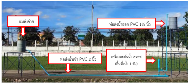
รูปที่ 4 การติดตั้งเครื่องตะบันน้ำและอุปกรณ์ประกอบ
