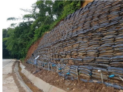
รูปที่ 10 ติดตั้งกระสอบแบบมีปีกเพื่อป้องกันการกัดเซาะผิวหน้า
