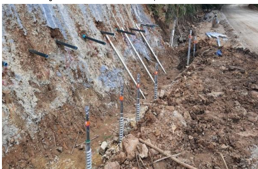
รูปที่ 8 แสดงขั้นตอนเจาะหลุมงาน Soil Nail
