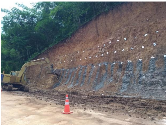
รูปที่ 8 แสดงขั้นตอนเจาะหลุมงาน Soil Nail
