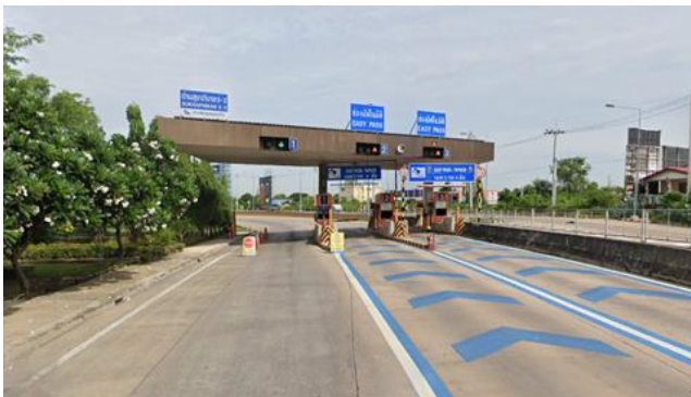
รูปที่ 2 ลักษณะทางกายภาพบริเวณหน้าด่านเก็บค่าผ่านทางพิเศษสุขาภิบาล 5-2 ก่อนการปรับปรุงกายภาพหน้าด่านฯ
