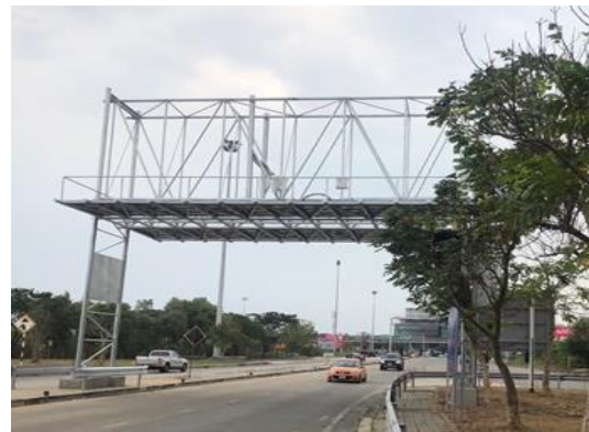
รูปที่ 4 โครงเหล็กคร่อมช่องจราจร (Overhead Gantry) บริเวณหน้าด่านเก็บ ค่าผ่านทางพิเศษสุขาภิบาล 5-2
