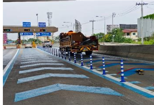
รูปที่ 3 ลักษณะทางกายภาพบริเวณหน้าด่านเก็บค่าผ่านทางพิเศษสุขาภิบาล 5-2 ภายหลังการปรับปรุงกายภาพหน้าด่านฯ
