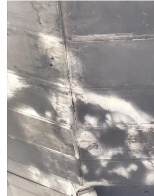
รูปที่ 3 สภาพความเสียหายภายนอกคานอัดแรงรูปกล่อง จากเหตุเพลิงไหม้ได้ทางพิเศษบูรพาวิถีบริเวณเสาตอม่อที่ 11/22 กม.11+800
