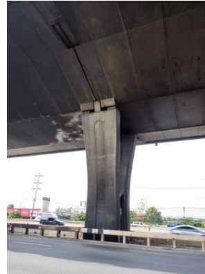
รูปที่ 3 สภาพความเสียหายภายนอกคานอัดแรงรูปกล่อง จากเหตุเพลิงไหม้ได้ทางพิเศษบูรพาวิถีบริเวณเสาตอม่อที่ 11/22 กม.11+800
