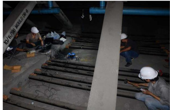
รูปที่ 17 การตรวจสอบแรงดึงของลวดภาคสนาม
