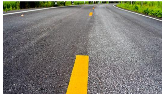
รูปที่ 7 ถนนสภาพดี Phase A
