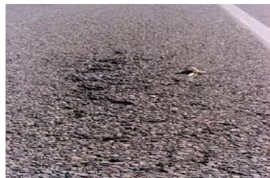
รูปที่ 3 ผิวทางหลุดร่อน (Raveling)
