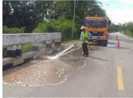
รูปที่ 11 ทำความสะอาดผิวจราจร
