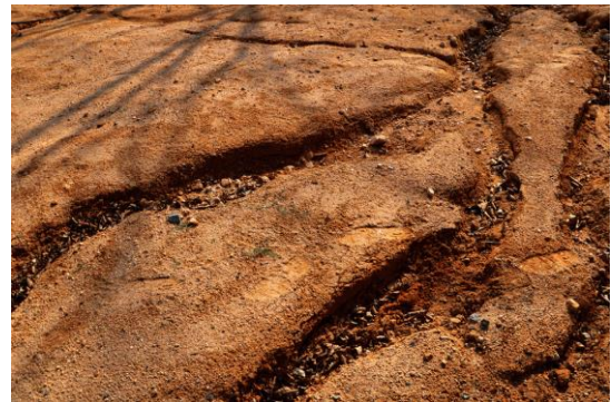
รูปที่ 1 การกร่อนแบบริ้วบริเวณผิวถนน (Rill erosion)
