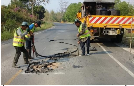
รูปที่ 16 การซ่อมผิวทาง (Deep Patching) กรณีความเสียหายเกิดขึ้นเป็นจุด
