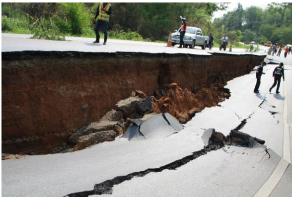
รูปที่ 11 สภาพการทรุดตัวของคันทางหลวงหมายเลข 118 กม.151-152 (ภาพโดยแขวงทางหลวงแม่สรวย)
