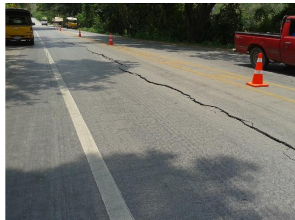
รูปที่ 10 รอยแตกบนผิวทางหลวงหมายเลข 118 กม.141-142 (ภาพโดยแขวงทางหลวงแม่สรวย)
