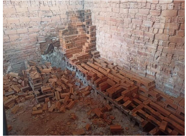
รูปที่ 2 เตาเผาอิฐ และการกองอิฐสำหรับเผา
