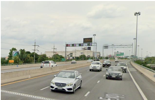
รูปที่ 3 ลักษณะทางกายภาพของการติดตั้ง และใช้งานกำแพงกันชนคอนกรีตบนโครงสร้างทางยกระดับของทางพิเศษ
