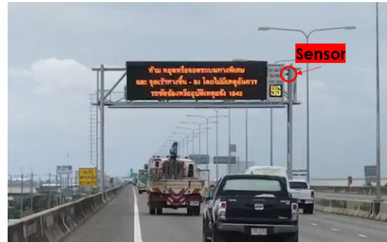
รูปที่ 2 ตำแหน่งติดตั้งป้ายแจ้งเตือนความเร็วและตำแหน่งอุปกรณ์ตรวจวัดสภาพจราจร (Sensor) ที่ใช้เก็บข้อมูล
