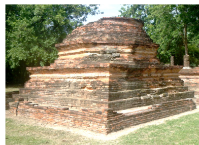
รูปที่ 3 ตัวอย่างความเสียหายของโครงสร้างอิฐวัดหนองตะกุ่ม [5]
