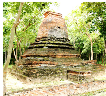
รูปที่ 2 ตัวอย่างความเสียหายของโครงสร้างอิฐวัดทัพเก่า [5]
